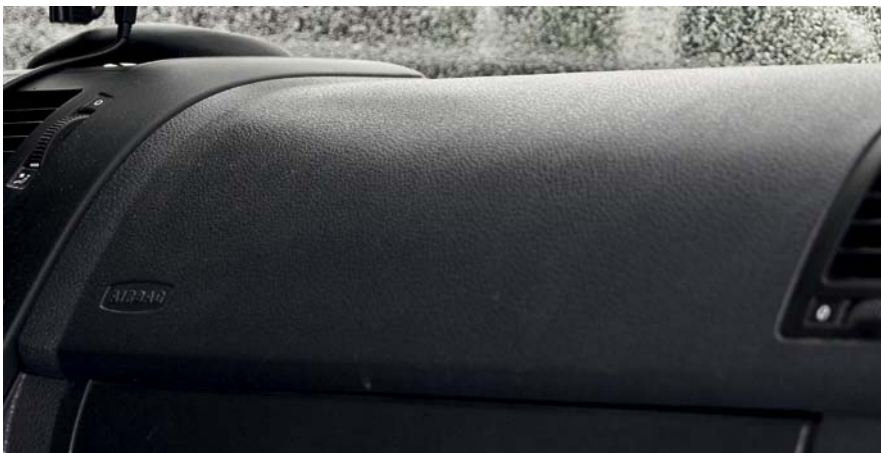
Bild 1. Dellen treten in der Instrumententafel an den Sollbruchstellen für Airbags auf. (Fotos: Wolfram Schmidt)
